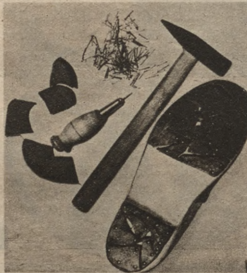
Ādas atgriezumi vai gumijas gabaliņi, plestīti pazolēm, pagarina ne tikai koka, bet arī ādas pazoļu mūžu.
